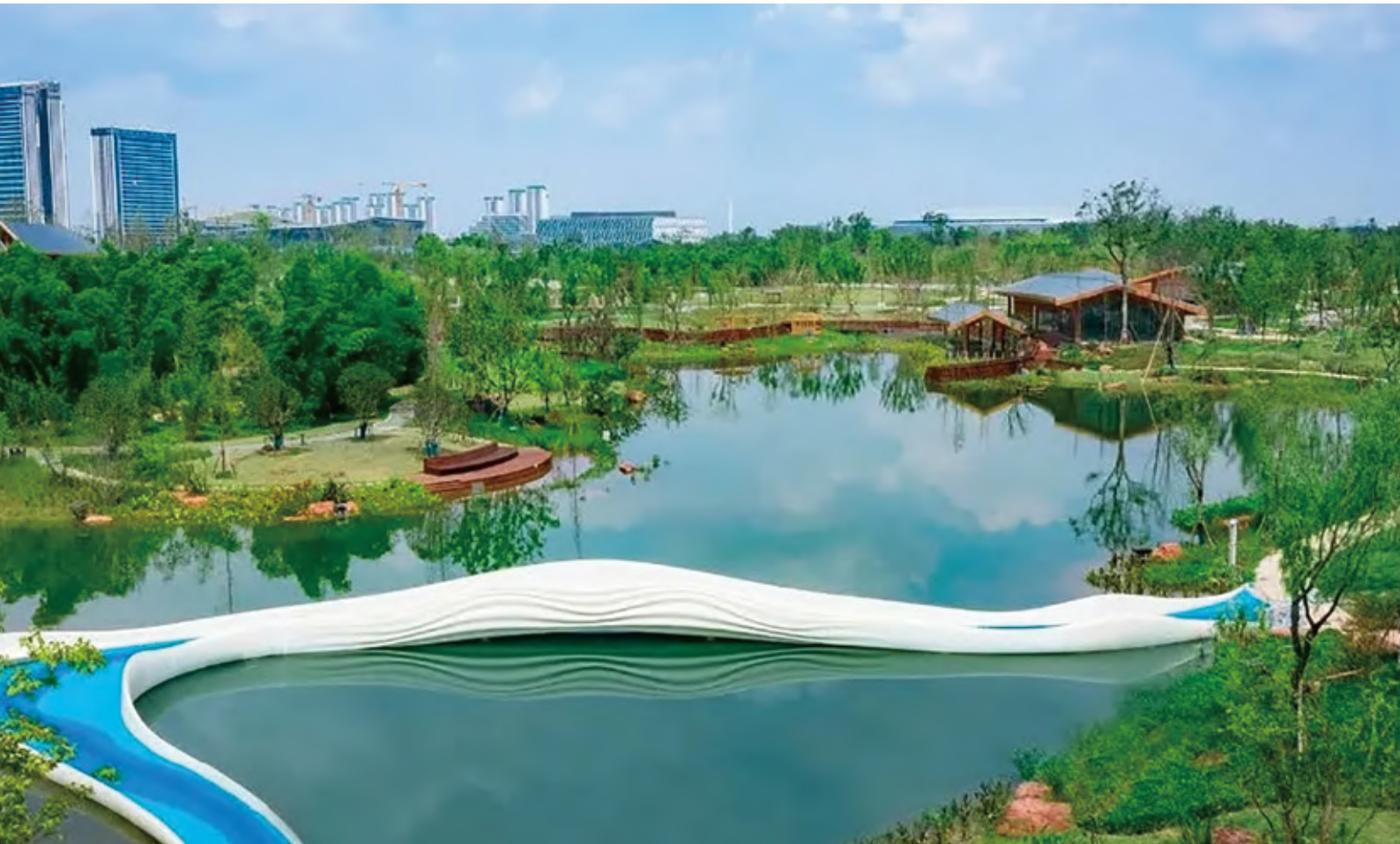
Polymaker製の素材で3Dプリンティングされた人道橋(中国・成都)
